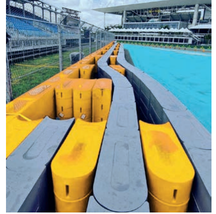
TecPro bariyerler çarpışma anında enerjiyi büyük ölçüde sönümler.
