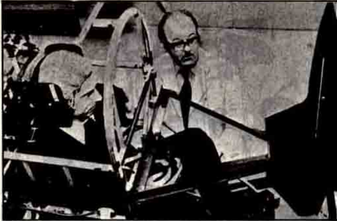
Dr. Ulf Merbold İngiliz Hava Kuvvetleri Hava Uçuşları Tıp Bölümünde (Farnborough'da) teste tâbi tutulurken. Bir santrifüjle dünya ivmesinin birkaç katına getirilir. Bu sırada görme yeteneğindeki değişiklik ve optik algı yeteneği ölçülür.
