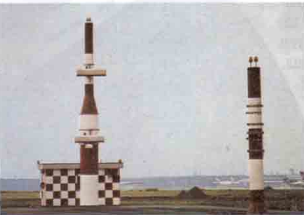
Süzülme rota vericisi: İki çapraz verici anteni, ışınları yukarıya doğru yansıtan düz bir yer alanına doğru yö- neltmiştir.
