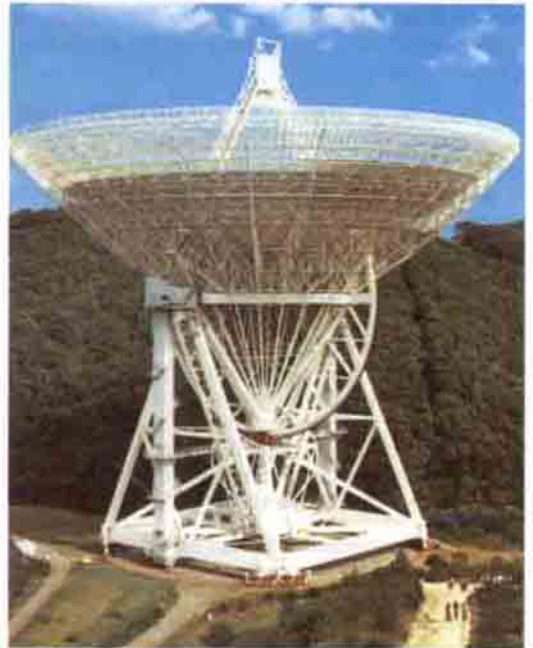
Şekil 3: Çanak antenli bir radyo teleskop. Bonn Max Planck Radyo-Astronomi Enstitüsü'ne ait olan bu teleskopun çapı 100 m toplam metal kütlesi 3200 tondur. Solda kontrol yapısı göze çarpıyor.
