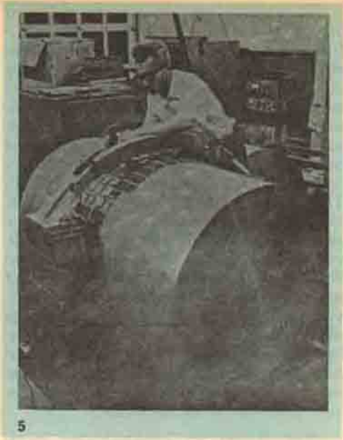
5-9-T-5) Resimde Prof. Weber ile gravitasyon detektrlerinden biri grlmektedir. Cihazın heybeti alminyum silindirel sarsılma yacak řekilde bir tele azalmıřtır. Onun zerinde piezoelektrik g deđiřtirici (transducer) (6) ve en ufak elektrik grlim oynamalarını kaydeden kristal keramik levhacıklar vardır. Onlar silindirin gravitasyon dalgaları tarafından oluřturulan titreřimlerini lerler. Silindirler -dođruftu anteni- olarak kullanılabilirler ve onlar yalnız silindirin eksenine dikoy durumda hassaslırlar. Yer zerinde dođu-batı dođruftusuna gre kondukları takdirde dnyanın dnř sayısında gkyznn mantarman taranmasına imkn verirler. (7) de gelen gravitasyon dalgalarına karřı duyarlı bir silindirle, (8) de duyar olmayan bir silindir grlmektedir.
