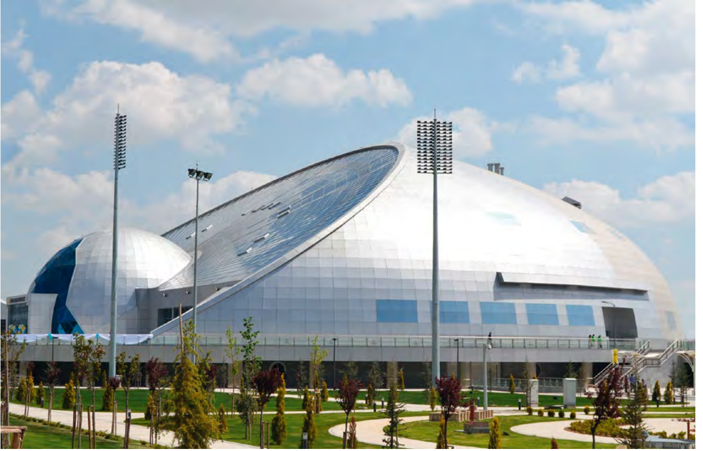
Konya Bilim Merkezi ana binasının inşaat bittikten sonraki görünüşü
