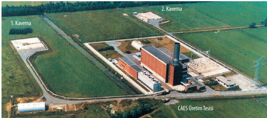
Huntorf CAES enerji tesisi (Almanya)
