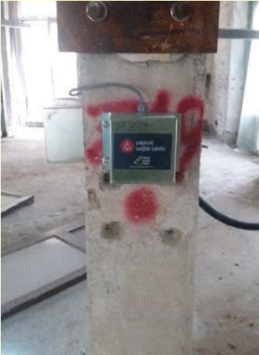
Binanın belirli noktalarına ivmeölçer adı verilen algılayıcılar yerleştiriliyor.
