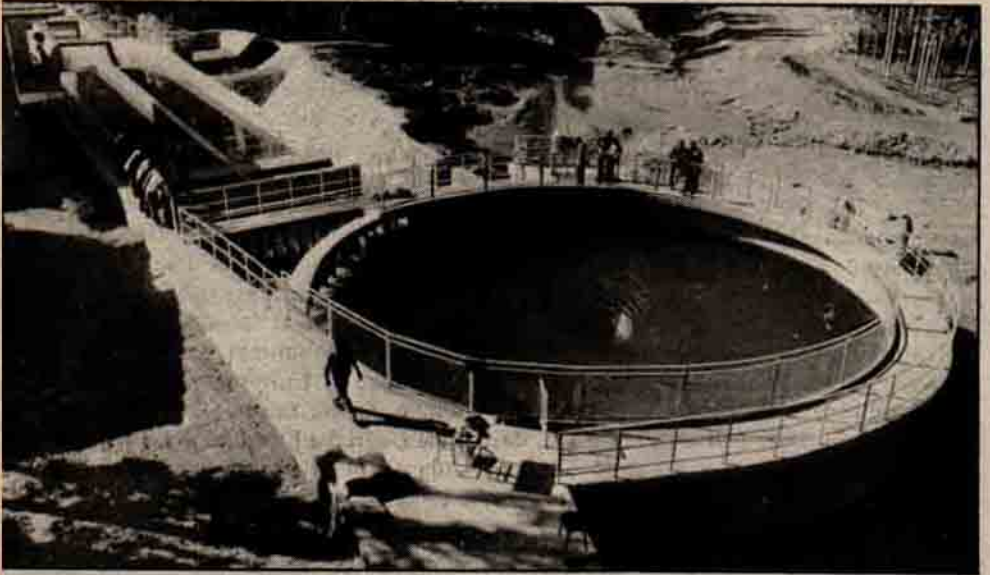
Resim 5— Dairesel Çöktürme havuzu (Sızır hidroelektrik tesisleri)
