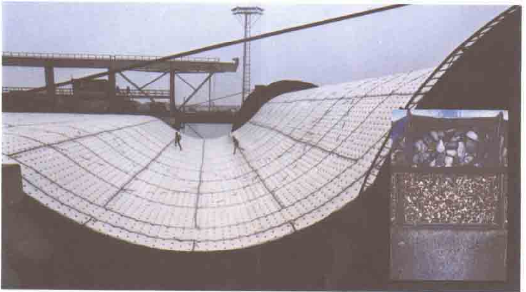
1. Deniz tabanı, 2-3. Kum, çakıl yatakları, 4. Payandalar, 5. Trafik şeridi, 6. Beton şapka, 7. Çelik kapı, 8. Hidrolik kapı asansörleri, 9-10. Şeritler, 11. Destek kayalar. Oosterschelde Seti'nin tamamlanmış hali (yanda). Deniz tabanına serilmek üzere hazırlandığı şantiye adasından nakledilen özel yataklar (alttaki resim). İnce kum, ince çakıl ve kaba çakıldan oluşan bir yatağın kesidi (küçük resim).
