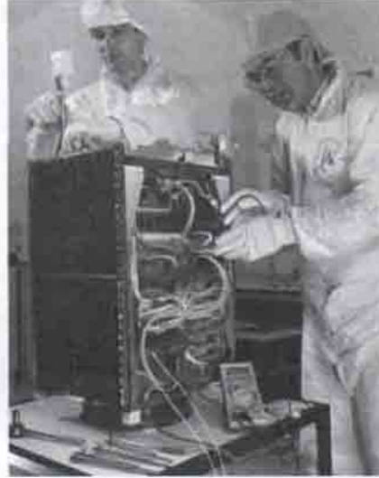
Amatör bir uydü olan UoSAT-F'nin üretim aşamalarından görüntüler. Üretim aşamasında çok temiz bir ortama ihtiyaç olduğundan çalışanlar da buna uygun giyinirler.
