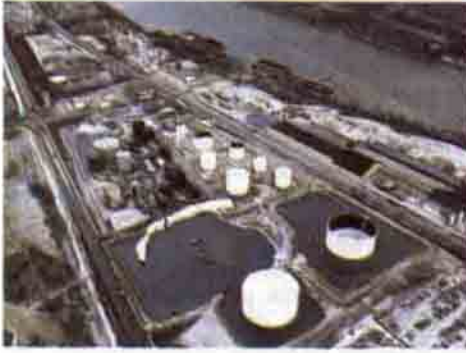
Ashland şirketinin kusurlu yakıt tankı ortadan yanıldı ve dizel yakıtının Monongahela Nehri'nin Pittsburgh'ta Ohio Nehri ile birleştiği noktanın biraz yukarısında nehre dökülmesine sebep oldu.
