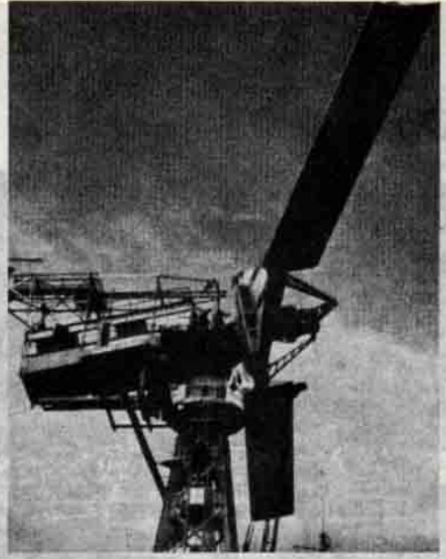
Dünyanın en büyük rüzgâr türbünü 1934'den 1945'e kadar Virginia (ABD) de işletilmiştir. Çapı 53,2 metre, 1250 KW.
