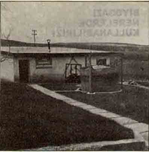
Sürekli besleme yöntemiyle çalışan bir üretcin biyogaz depolama tankı.
