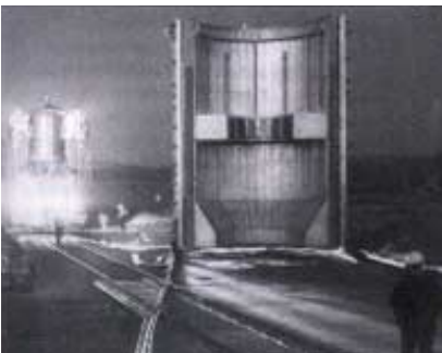
ABD Uzay Nükleer İtke Dairesi, 1967 Aralık ayında Nevada'daki Jackass Flats deneme alanında (parçaların yakıt konmamış) nükleer roket motoruyla bir "soğuk akış" denemesi gerçekleştirdi.
