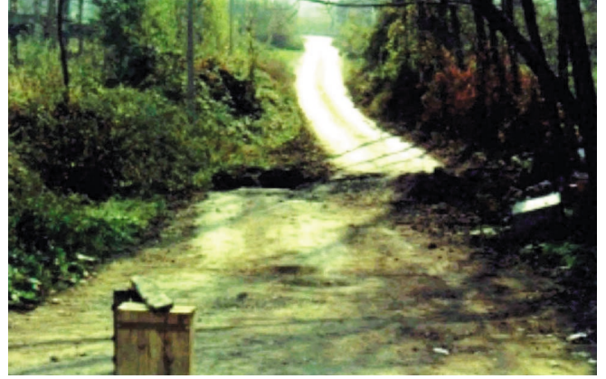
Şekil 3. Hacıyakup yakınlarında fay boyunca ana yolun 2m'lik düşey atımı ve Kaynaşlı'da fayın 2.5 m'lik doğrultu atımı gösterilmektedir. Burada 40 cm'lik düşey atımda görülmektedir.
