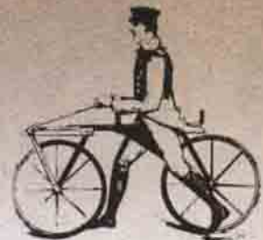
"The Draisine", Alman Baron Karl von Drais tarafından 1816 yılında geliştirilen pedalsız bisiklet
