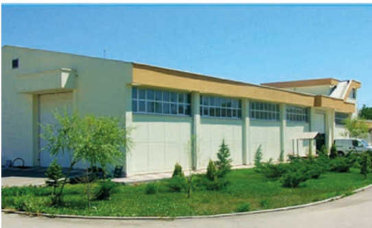
TAEK Gama Işınlama Tesisi
