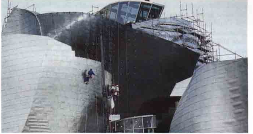
Titanyumla kaplanan bina için 20 000 üzerinde plan hazırlandı. Binanın yapımı iki buçuk yıl sürdü. Çelik konstrüksiyon üzerine perçinlenen bu titanyum tabakaları geminin güçlü koruyucu kalkanlarını oluşturuyor!
