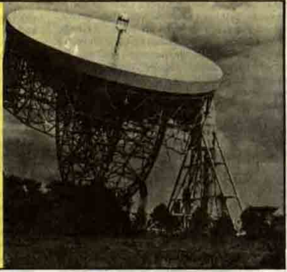
Şekil: 4. Bir radyo teleskop. İngiltere'de Jodrell Bank'da bulunan bu cihazın çapı 75 metredir. Resmin sağ alt köşesinde Jodrell Bank'daki teleskoplardan biri daha görülmüyor.
