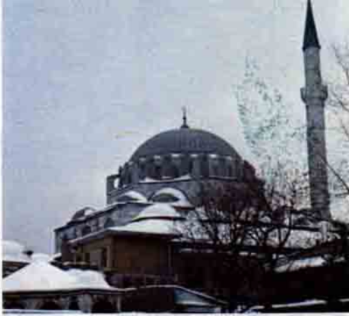
Rüstem Paşa Camii
