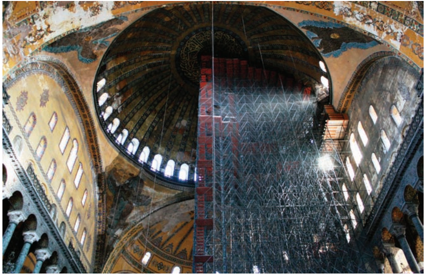
İmparator Justinian'ın 6. yüzyılda yaptırdığı Ayasofya, Osmanlı camilerini de etkileyen büyük bir mimari atılımdır. Ancak bünyesinde taşıdığı yapısal sorunlar, kubbesinin günümüze kadar birkaç kez çökmesine neden olmuştur.
