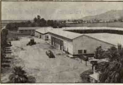
Modern tarım işletmesi merkezi.
