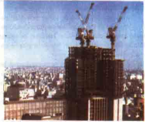
Gökdelenlerde emniyet: Çelik iskelet. Çelik en iyi ve en pahalı, depreme karşı güvenli bir inşaatır. Diagonal olarak yönlendirilmesi binaya tam bir sağlamlık verir.
