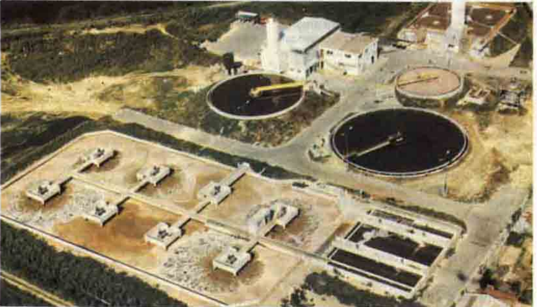
Bir kimya fabrikasının temizleme istasyonunu gösteren bu fotoğrafta, dairesel biçimli süzücü düzenekler ve dikdörtgen biçimli havalandırma havuzu görülmüştür.
