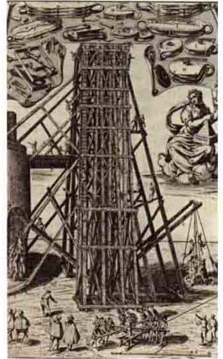
1586'da, obelisklerden birinin Papa'nın isteği üzerine Roma'da St. Peter Meydanı'na yeniden dikilmesi için, Fontana'nın projesini uygulamak üzere 26 metrelik bir ahşap kule inşa edilmiş ve 900 adam, 74 at, 13 km'lik 3 cm çapında halat ve 48 ırgat kullanılmış.
