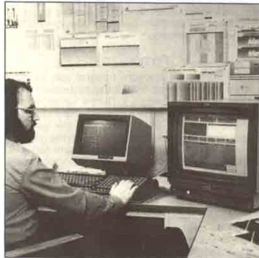
Fotoğrafta bir fotodizgi ünitesinin klavye ve ekran terminali görülmektedir. Fotodizgi sisteminde kurşun harflerdeki fiziksel kısıtlamalar ortadan kalkar. Harfler istendiği gibi espaslanabilir, hatta üstüste bindirilebilir.
