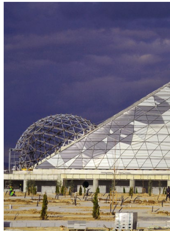
Çapı 110 m olan jeodezik kubbe yapısındaki Konya Bilim Merkezi ana binası inşaatı
