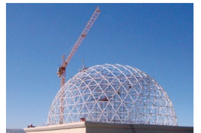
Jeodezik kubbeler tıpkı bir sepet gibi, yukarı doğru örülerek inşa ediliyor.
