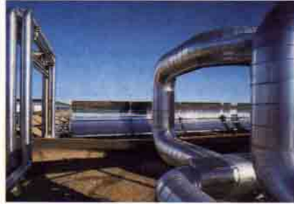
Amerika Mojave çölündeki Luz Santral'i'nde, güneş ışınlarını toplayan parabolik yansıtıcılar ve bu yansıtıcılar yardımıyla ısınan sıvıyı toplayan büyük borular.
