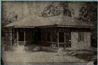
ŞEKİL : 6 Hindistan'da ahşap iskeletli bir dağ evi.
