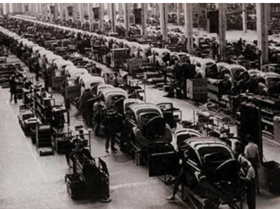
Ford'dan sonra otomobil üretiminde birçok yenilikler olduysa da üretim bandı kullanılması sürdürülmüştür. Böylece ucuza mal edilen otomobiller çok sayıda insanın satın alabileceği kadar ucuzladı ve yaygınlaştı.
