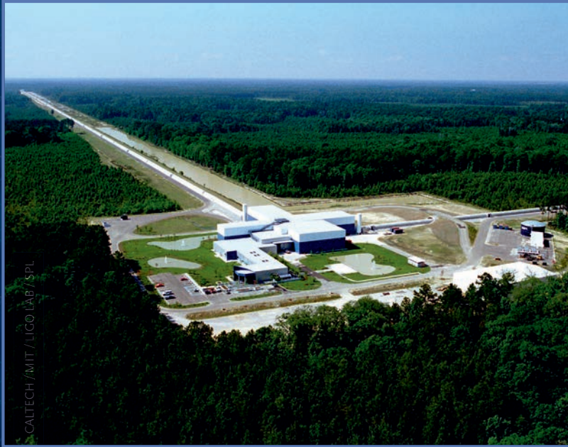
ABD'nin Louisiana eyaletinde yer alan LIGO detektörü. LIGO ikiz detektörlerinin diğeri ise Washington eyaletinde yer alıyor. İkiz detektörlerdeki girişim ölçerlerin her bir kolu dört kilometre uzunluğunda.
