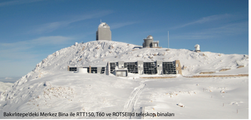
Bakırlıtepe'deki Merkez Bina ile RTT150, T60 ve ROTSEII'd teleskop binaları
