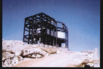
150 cm teleskop binası inşaatı
