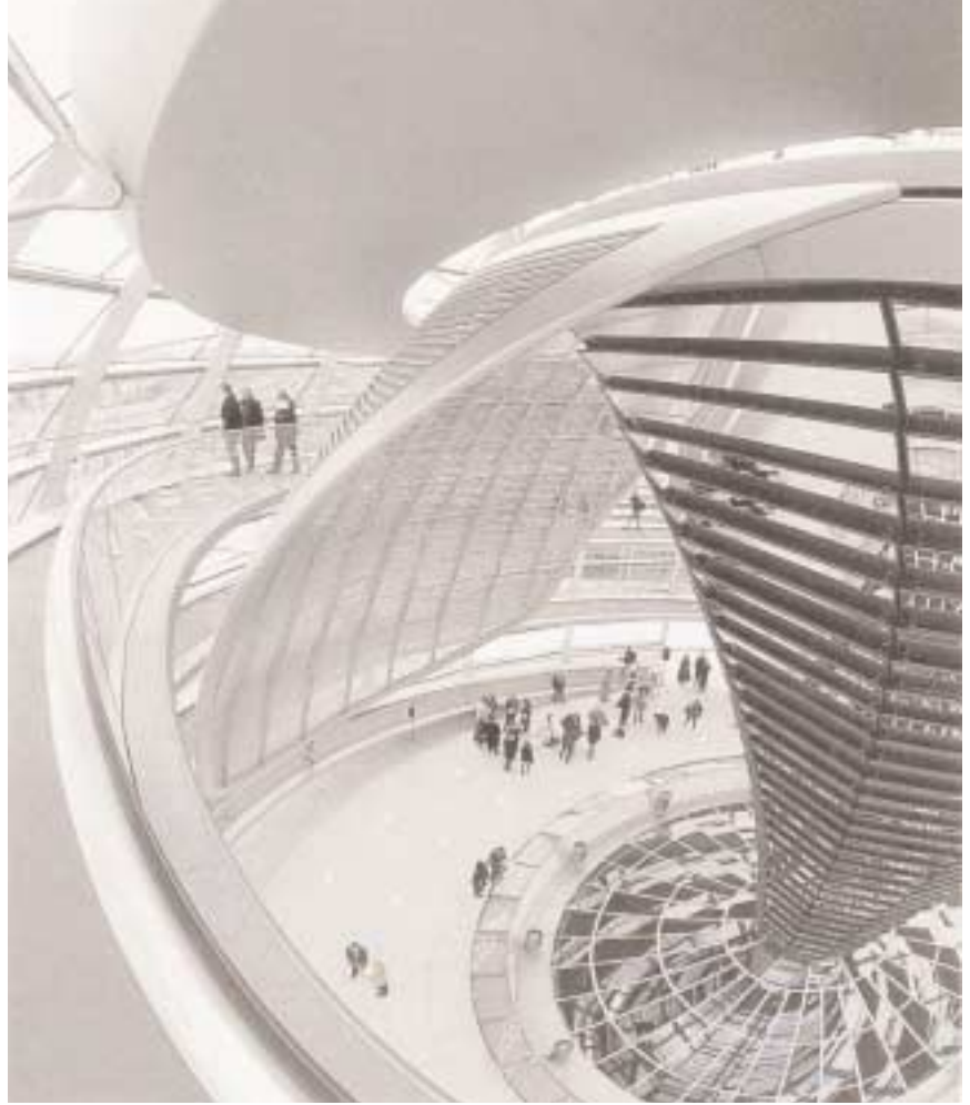
Aynalarla kaplanmış havalandırma, aydınlatma bacası ve güneş kontrol panelleri enerjisini fotovoltaiklerden sağlıyor.
