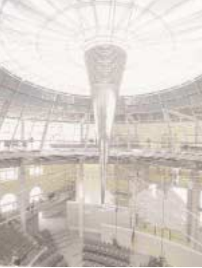
Aynalarla kaplanmış havalandırma, aydınlatma bacası ve güneş kontrol panelleri enerjisini fotovoltaiklerden sağlıyor.
