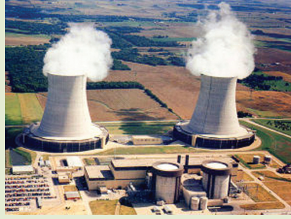
Silindirik şeklindeki koruma binalarının içinde iki nükleer reaktör ünitesi ve arkada soğutma kuleleri.
