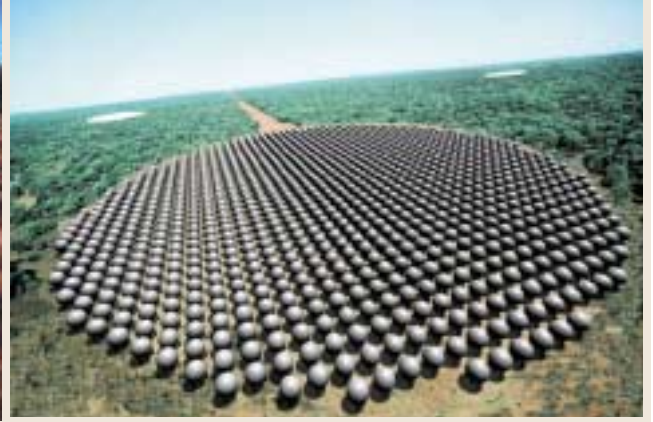
SKA teleskobu için önerilen tasarımlardan biri küresel radyo antenleri aracılığıyla teleskobun radyo dalgalarını topladığı alanın artırılmasını hedefliyor. © SKA
