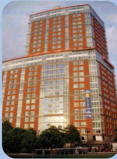
New York'taki Solaire binası, yeşil teknolojinin güzel örneklerinden biri. Bina, güneş pilleri sayesinde yıllık 34.300 kilowatt-saat enerji üretiyor.
